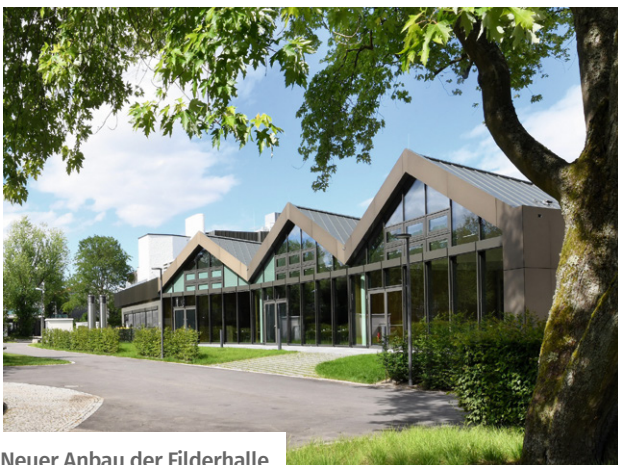
Neuer Anbau der Filderhalle
