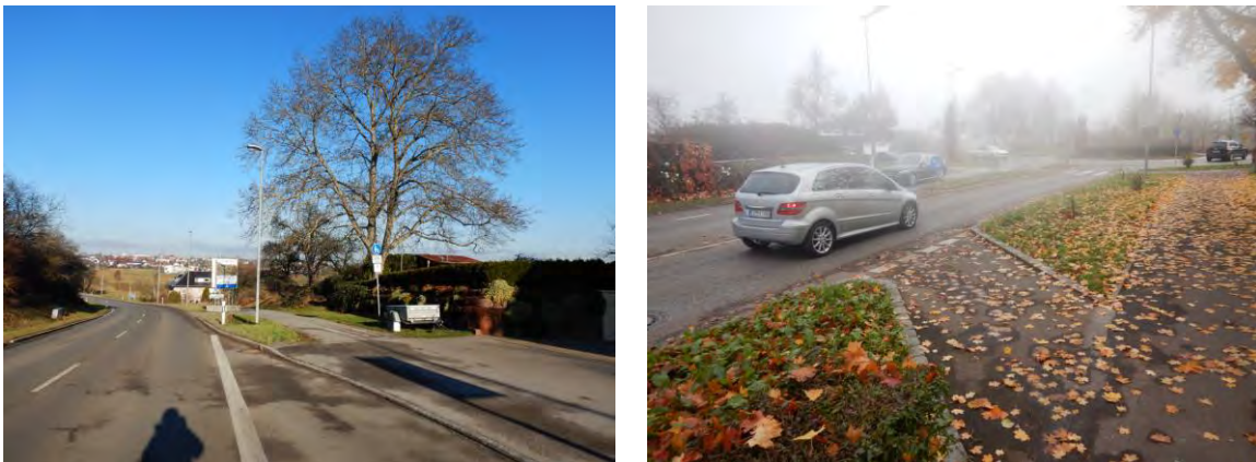
Abbildung 8: Fehlende Überführung auf Radweg am Ortsausgang Stetten Richtung Echterdingen (links), ungeeignete Überführung auf die Fahrbahn am Kreisverkehr in der Rohrer Straße (rechts)
