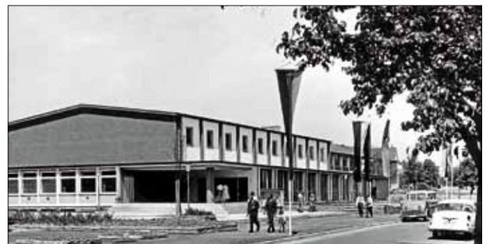
Die neu errichtete Filderhalle 1958
